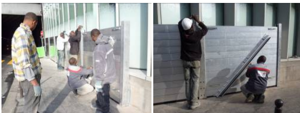
8h45 - Fin de mise en place des batardeaux - Début de mise en place de la ligne de protection inclinée sur la rue de Rambouillet
