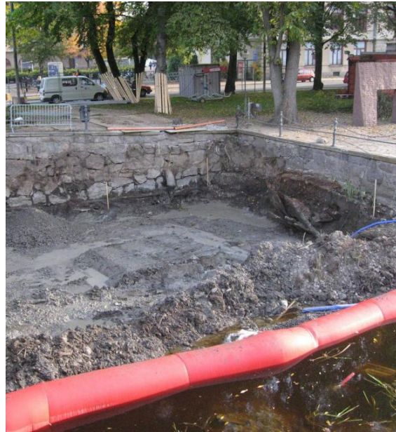
Utilisation dans le cadre de chantiers
