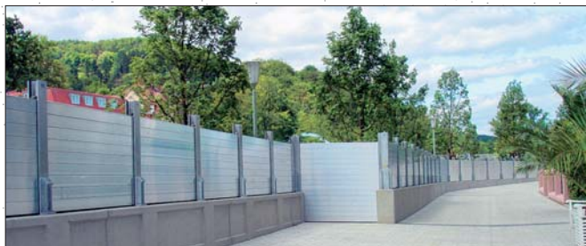
Roseraie derrière le dispositif anti-crue démontable.
