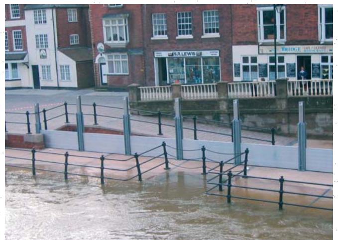
Après l'installation des poutres inférieures, la hauteur de la protection peut être augmentée par paliers.
