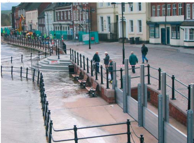
Le dispositif est érigé en premier lieu sur sa hauteur maximale.
