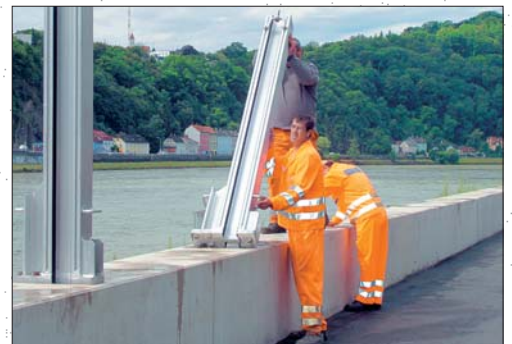
Les poteaux d'une hauteur de 2,50 m sont érigés manuellement.
