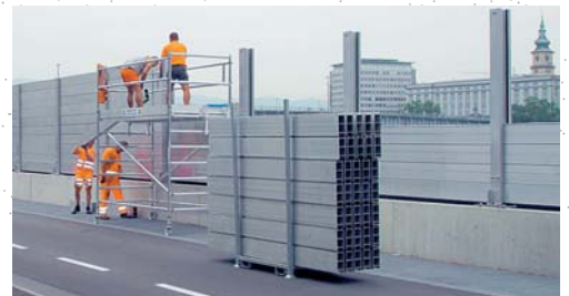
Une hauteur de 2,50 m du mur est atteinte avec seulement dix poutres par panneau répartis sur deux phases de construction.
