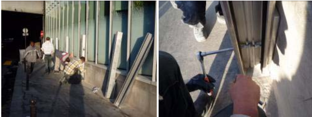
8h00 - Fin de montage des poteaux - Début de mise en place des batardeaux (ou poutres)
