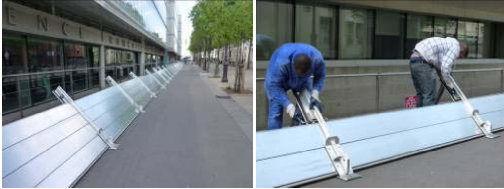
12h00 - Début de montage de la protection sur la pointe du bâtiment
