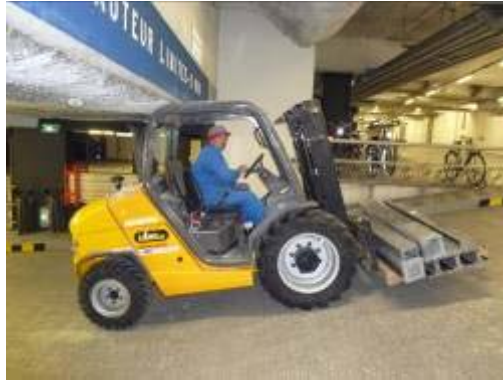
7h15 - Montage des poteaux verticaux sur la rue de Rambouillet
