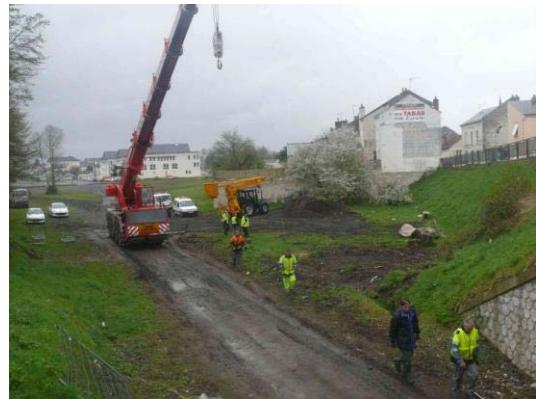
Test traction Pont du Pressoir 22 tonnes Hauteur de protection H=4000 mm
