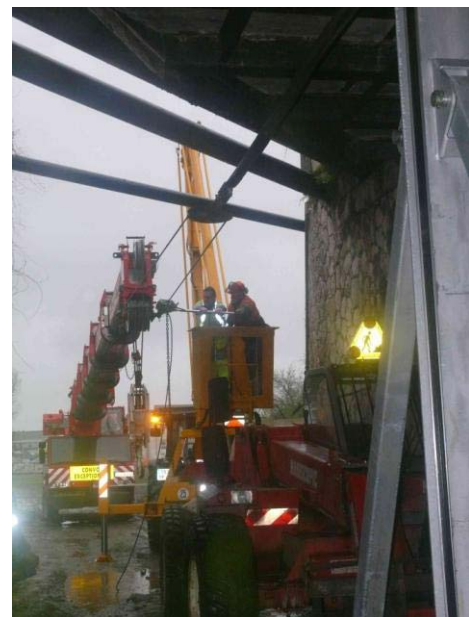
Test traction Pont du Pressoir 22 tonnes Hauteur de protection H=4000 mm
