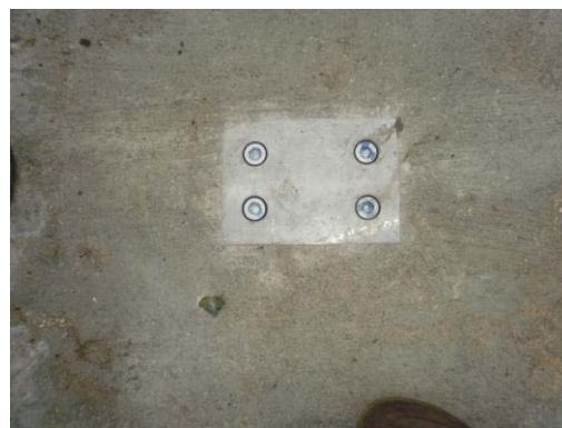
Photo 3: Platine inox coulée dans les fondations et restant à demeure sur le sol venant recevoir le poteau central
