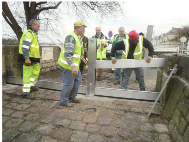
Photo 2: Montage d'une grande ouverture
