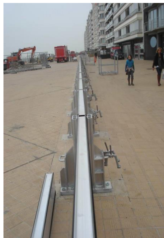
Figure 15 : Système de batardeau anti-crue pour protection contre la houle marine – Ostende - Belgique par (Source : www.esthifrance.com )
