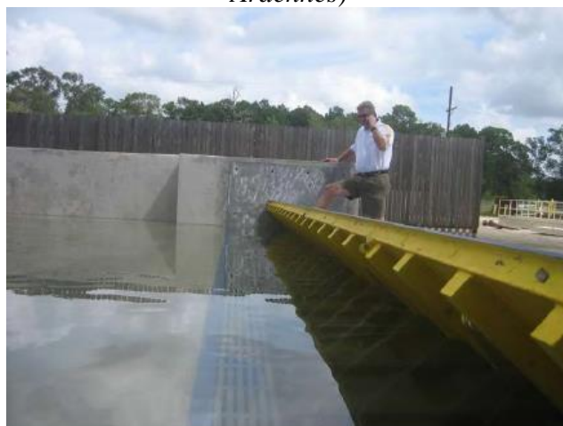
Figure 12 : Système de batardeau anti-crue passif 'Flolift-H' – le dispositif se soulève par la simple poussée de l'eau sans intervention humaine ni énergie (Source : www.esthifrance.com )
