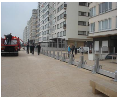
Figure 15 : Système de batardeau anti-crue pour protection contre la houle marine – Ostende - Belgique par (Source : www.esthifrance.com )
