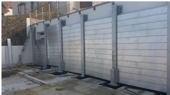
Figure 14 : Système de batardeau anti-crue pour protection contre la houle marine – Thalasso de Douarnenez- réalisation 2001 (Source : www.esthifrance.com )
