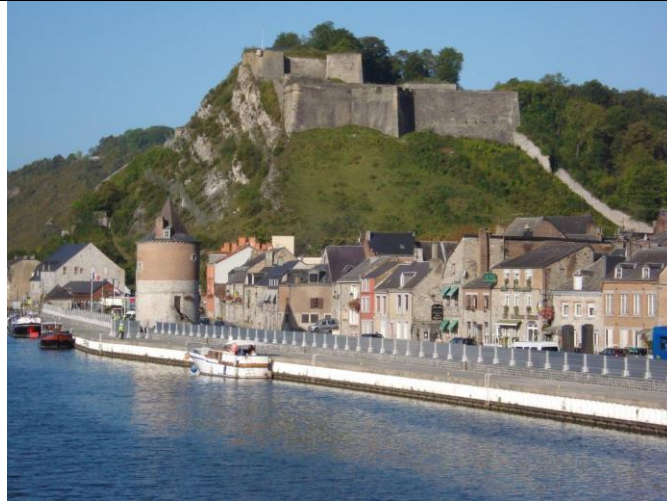
Figure 10 : Une partie montée du batardeau amovible anti-crue de la ville de Givet (Source www.esthifrance.com )
