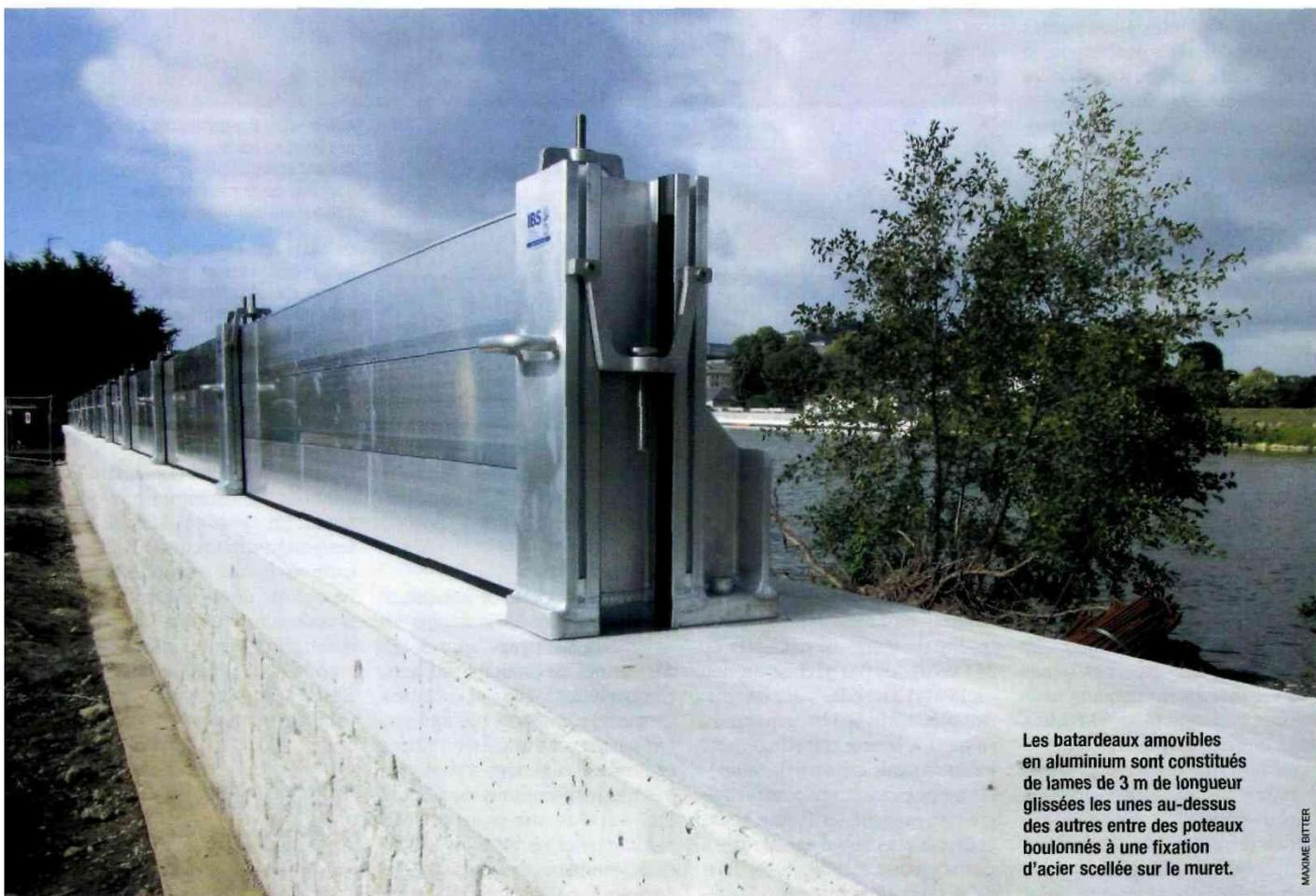
Les batardeaux amovibles en aluminium sont constitués de lames de 3 m de longueur glissées les unes au-dessus des autres entre des poteaux boulonnés à une fixation d'acier scellée sur le muret.
