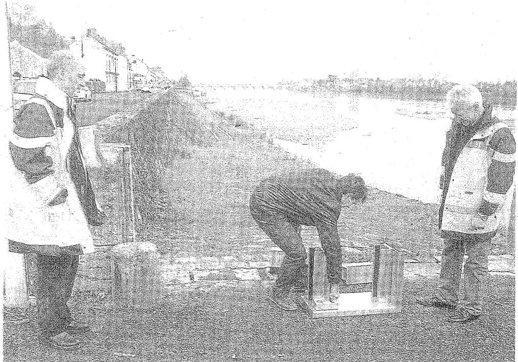
Saumur, quai Maynaud, début décembre. À l'aide d'un échantillon, Loïc Perret, le gérant de l'entreprise ESTHI, montre à Patrick Daviaud, l'élus en charge de la sécurité, le principe de pose des bouchures en aluminium.
