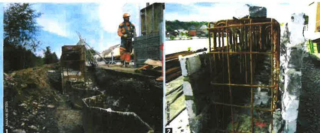
**2 et 3** La pierre bleue de Givet ne sert pas qu'au parement du muret. Pour accélérer la construction dans le centre historique et libérer ce cœur touristique, Bouygues a utilisé la pierre bleue de 10 à 15 cm d'épaisseur comme coffrage à béton. Une technique qui n'a pu être naturellement utilisée que lorsque le parement était disposé de chaque côté du muret.
