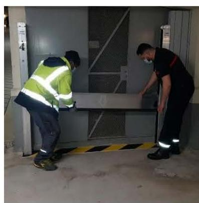
Après avoir testé deux prototypes permettant de mieux appréhender les besoins, la société a choisi un modèle nécessitant la mise en place de guides autour des équipements dans lesquels sont emboîtées des planches qui font barrage à l'infiltration d'eau. Afin de garantir une parfaite étanchéité, une **mise à niveau du sol** a également été effectuée sur plusieurs ouvertures : chaque batardeau, adapté sur mesure pour chaque équipement sensible, représente donc un chantier à part entière.
