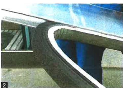
■ Haute de 90 ou 135 cm, la protection périphérique de l'AFD garderait le rez-de-chaussée du bâtiment au sec même en cas de crue type 1910 (60 cm d'eau dans la rue). ■ L'espace entre les lames superposées est rendu étanche par un joint. ■ Déployé sur près de 300 m, le système peut être monté en moins d'une journée par six personnes munies d'un outillage basique. ■ La stabilité est assurée par une plaque de sol, un pied et le poids de l'eau.
