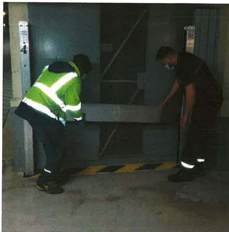
Exercice d'installation d'un batardeau © PariSeine
