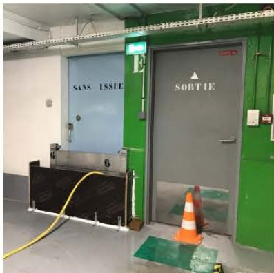
Test d'étanchéité d'un batardeau - © PariSeine
