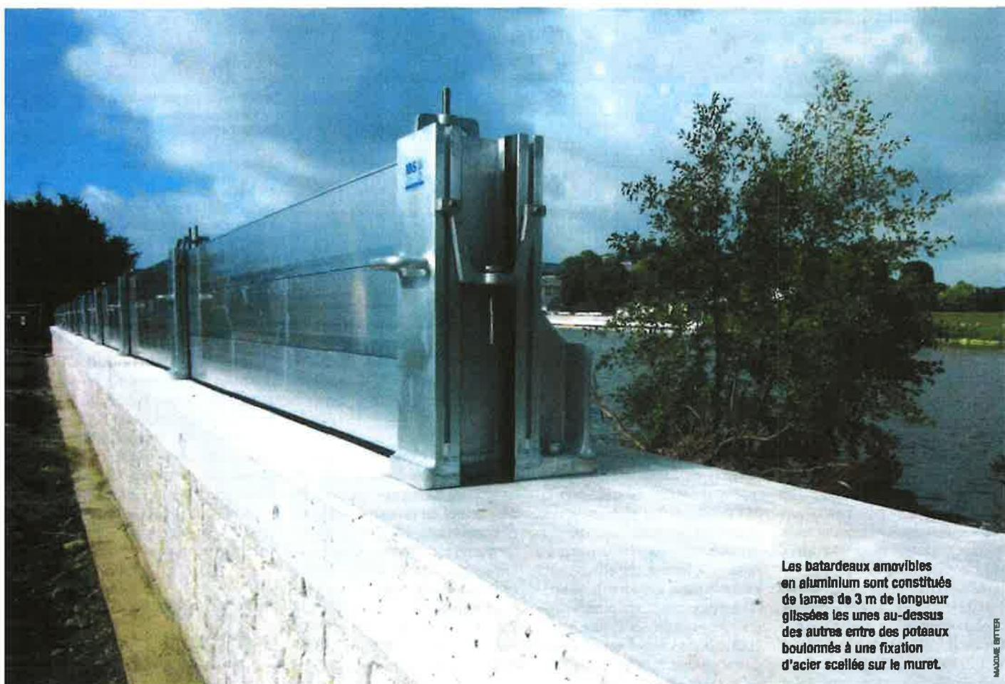
Les batardeaux amovibles en aluminium sont constitués de lames de 3 m de longueur glissées les unes au-dessus des autres entre des poteaux bouloinés à une fixation d'acier scellée sur le muret.
