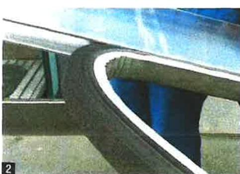
■ Haute de 90 ou 135 cm, la protection périphérique de l'AFD garderait le rez-de-chaussée du bâtiment au sec même en cas de crue type 1910 (60 cm d'eau dans la rue). ■ L'espace entre les lames superposées est rendu étanche par un joint. ■ Déployé sur près de 300 m, le système peut être monté en moins d'une journée par six personnes munies d'un outillage basique. ■ La stabilité est assurée par une plaque de sol, un pied et le poids de l'eau.
