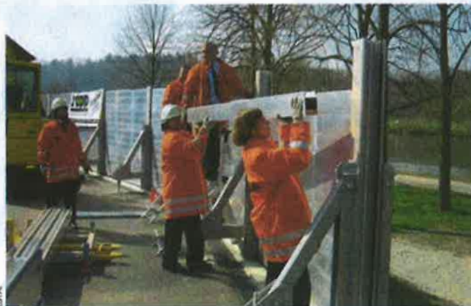
La barrière anticrue est constituée de poteaux et de panneaux en aluminium amovibles. Pourvu que les équipes de montage soient suffisamment nombreuses, les 13200 m 2 peuvent être montés en 24 heures en cas d'alerte.
