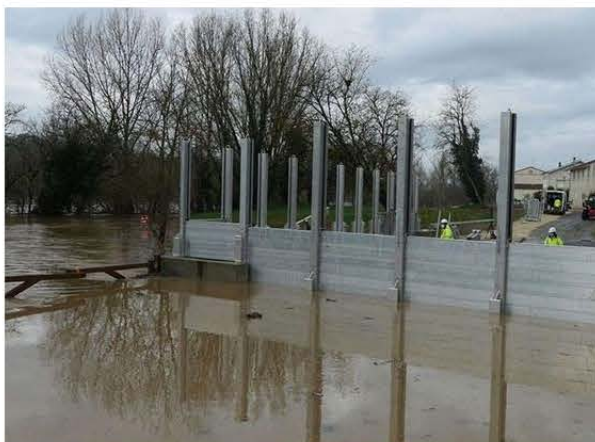
Barrières anti-inondation ESTHI en fonctionnement - © ESTHI
