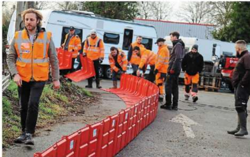
Les blocs étanches s'empilent vite. Des agents municipaux de plusieurs communes ont testé le dispositif anti-crues provisoire, dans le cadre du nouveau plan intercommunal de sauvegarde. (PHOTO: OUEST-FRANCE)
