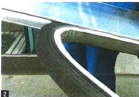
■ Haute de 90 ou 135 cm, la protection périphérique de l'AFD garderait le rez-de-chaussée du bâtiment au sec même en cas de crue type 1910 (60 cm d'eau dans la rue). ■ L'espace entre les lames superposées est rendu étanche par un joint. ■ Déployé sur près de 300 m, le système peut être monté en moins d'une journée par six personnes munies d'un outilage basique. ■ La stabilité est assurée par une plaque de sol, un pied et le poids de l'eau.
