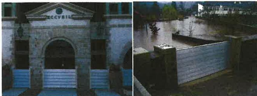
La gamme de batardeaux en aluminium représente une solution ingénieuse pour se prémunir des inondations. Ces barrières peuvent être installées pour offrir une protection sur une hauteur variable allant de quelques centimètres à plusieurs mètres d'eau. Grâce à leurs multiples options de montage, elles sont conçues pour répondre à des exigences spécifiques de protection. De plus, les glissières sont personnalisables aux couleurs du bâtiment, conciliant ainsi esthétique et fonctionnalité.
