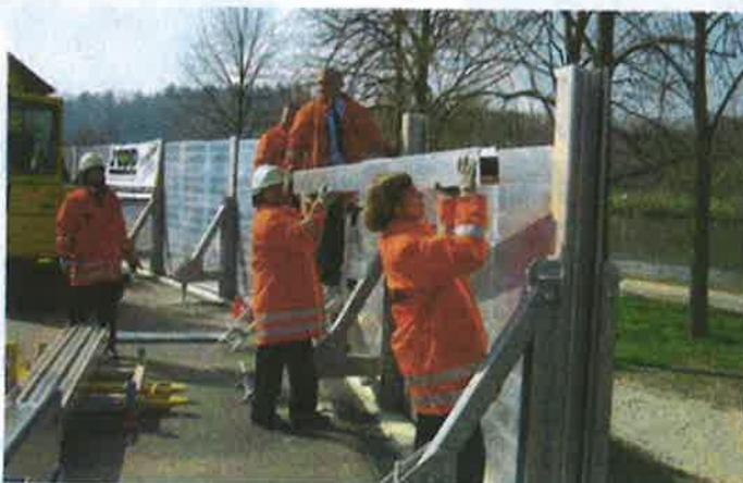
La barrière anticrue est constituée de poteaux et de panneaux en aluminium amovibles. Pourvu que les équipes de montage soient suffisamment nombreuses, les 13200 m<sup>2</sup> peuvent être montés en 24 heures en cas d'alerte.
