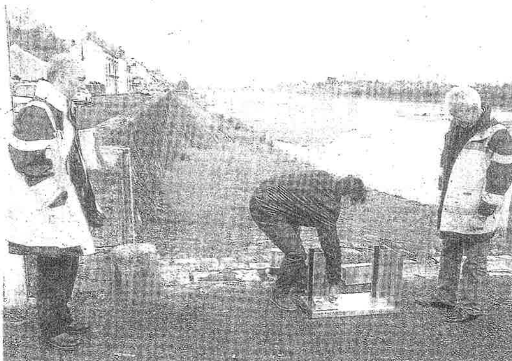
Saumur, quai Mayaud, début décembre. À l'aide d'un échantillon, Loïc Perret, le gérant de l'entreprise ESTHI, montre à Patrick Daviaud, l'élue en charge de la sécurité, le principe de pose des bouchures en aluminium.
