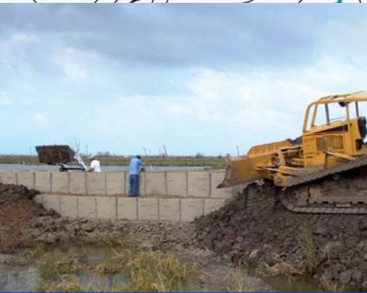
RÉPARATION DE BRECHES
