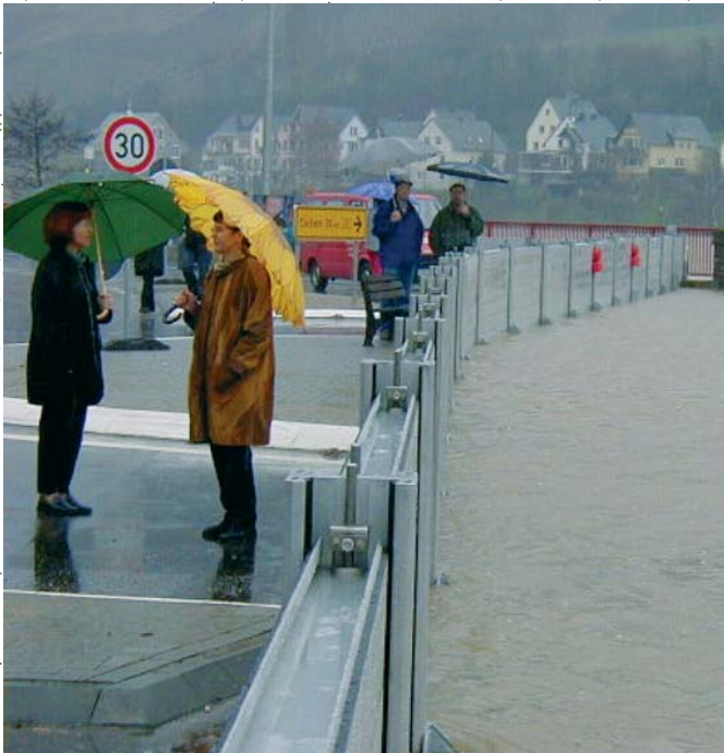
Le dispositif anti-crue démontable d'IBS ...
