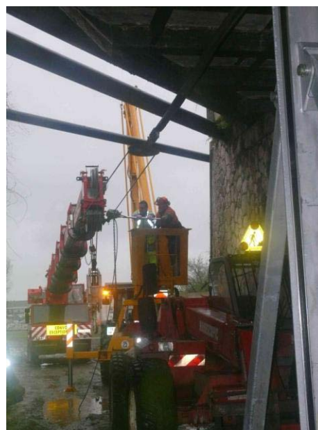
Test traction Pont du Pressoir 22 tonnes Hauteur de protection H=4000 mm
