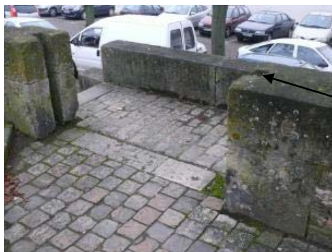
Photo 1: Exemple d'une petite ouverture (avant pose des glissières)
