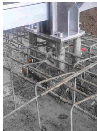
Photo 5: Coulage de la platine du poteau central
