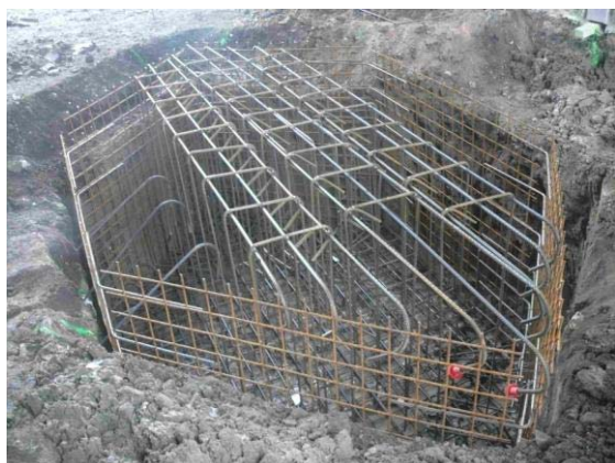
Photo 4: Fondation du Pont du Pressoir
