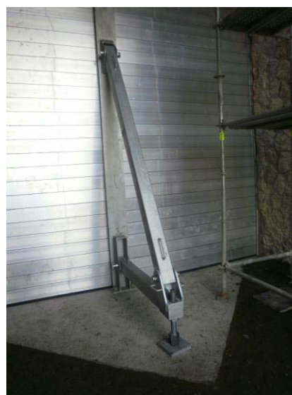
Photo 7: Détail de la jambe de force du Pont du Pressoir
