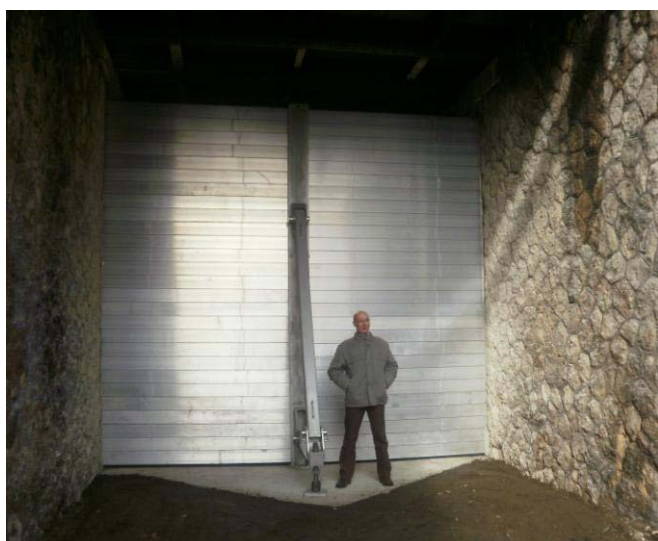
Photo 6: Barrière anti-crue démontable du Pont du Pressoir montée
