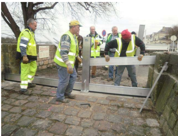
Photo 2: Montage d'une grande ouverture
