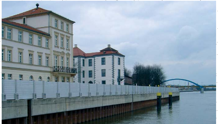
Lorsque le dispositif anti-crue démontable est en place, les riverains peuvent observer le niveau montant en toute sérénité.
