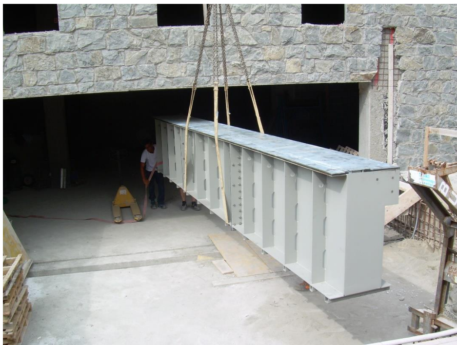
Cuve acier du FloLift-V avec la barrière à l'intérieur prête à être posée dans la fouille
