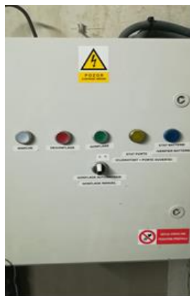
Boitier de commande associé à un bouton poussoir / capteur de liquide (Le boitier de commande doit être coté sec ou au dessus de l'eau)
