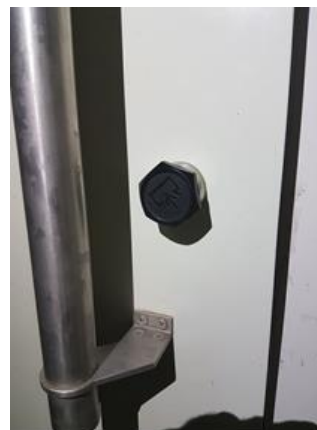
Barre de tirage et capuchon d'étanchéité de la serrure coté eau (pour modèle 2.5/5 mCE). Dans ce cas la béquille n'est pas traversante et l'ouverture côté eau doit se faire avec une clef.
