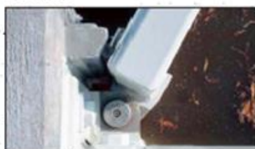
Connexion au mur de départ
