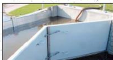
Test de fuite
