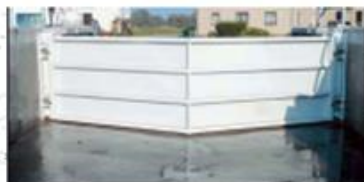
Vue depuis coté eau
