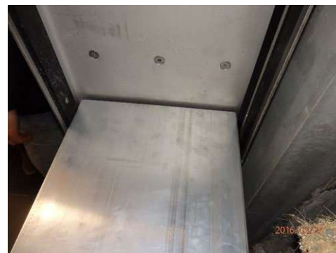
DETAIL JOINTS SUR GLISSIERES INOX
