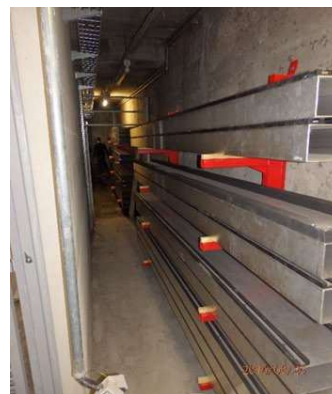
EXEMPLE DE STOCKAGE DES POUTRELLES
