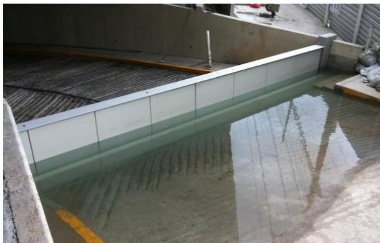
FLO-LIFT V est une barrière anti-inondation. Hors épisode de crue, elle est cachée à l'intérieur d'une réservation, permettant la circulation de piétons et de véhicules poids lourds au-dessus (Limitée à 45 Tonnes par essieu).
