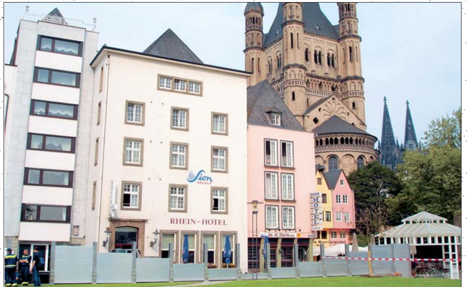
Inauguration du nouveau mur de protection anti-crue dans la zone de la vieille ville de Cologne.
