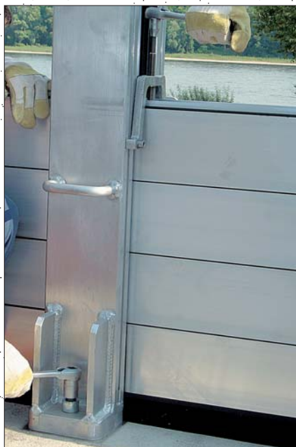
Vissage du pied de poteau central et de la cale de serrage.
