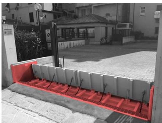
Le terme « Base » réfère à la structure dans laquelle vient se reposer le clapet au repos.
