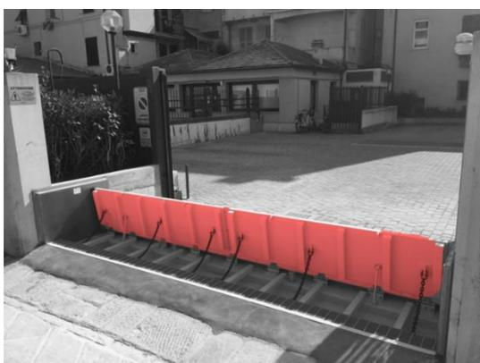
Le terme « Clapet » réfère à la partie flottante du système.
